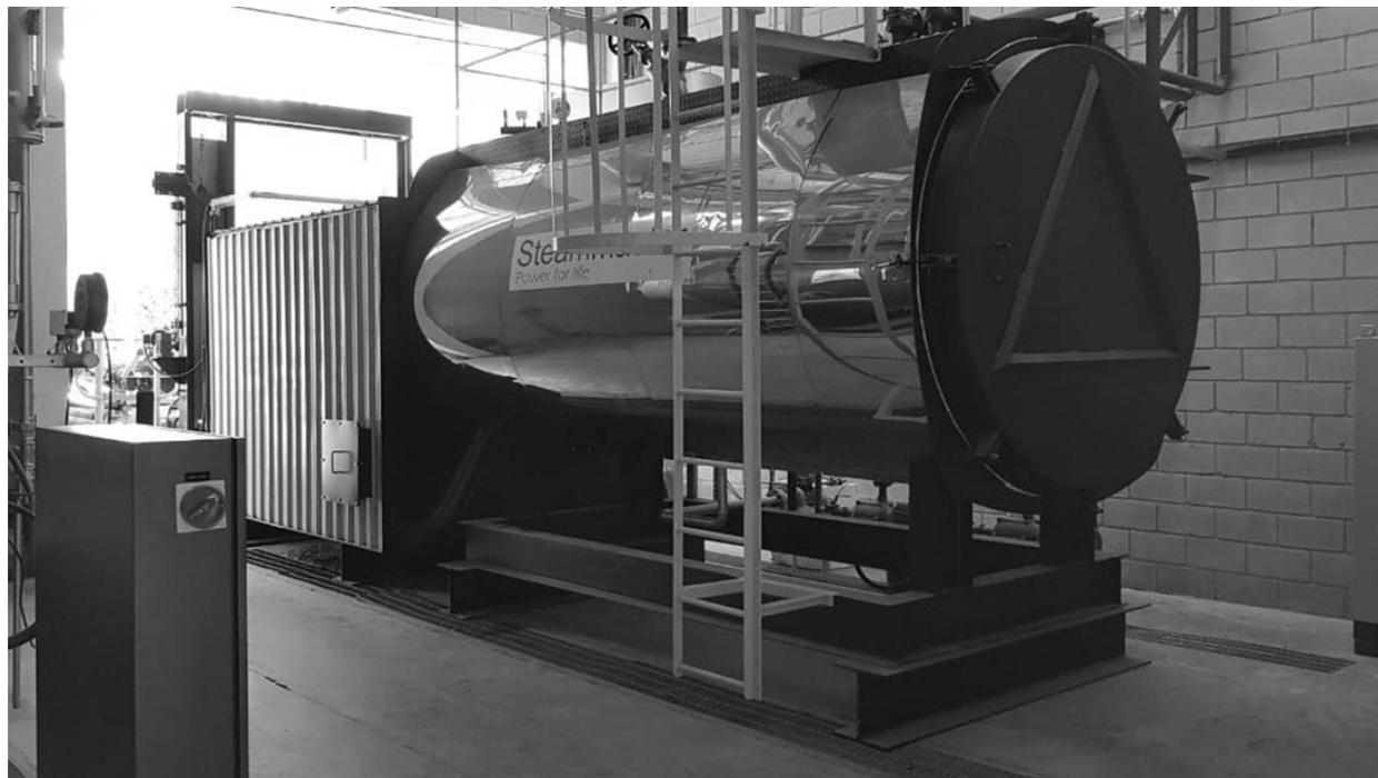
Caldeira flamotubular, vapor saturado, fornalha externa aquatubular, com **circuito de troca térmica de 03 passes dos gases**, fornecida montada em um único conjunto .
