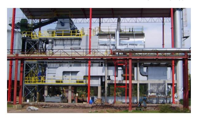
Caldeira flamotubular, vapor saturado, fornalha aquatubular e grelha em módulos, circuito de troca térmica composto de 03 passes dos gases. Este equipamento segue desmontado em dois módulos para agilizar a montagem em campo e facilitar o transporte. O módulo superior é compostos da caldeira e fornalha com Préaquecedor de ar integrado, garantindo maior economia de combustível. O módulo inferior é composto pela grelha móvel reciprogrelha ideal para queima do combustível requerido.
